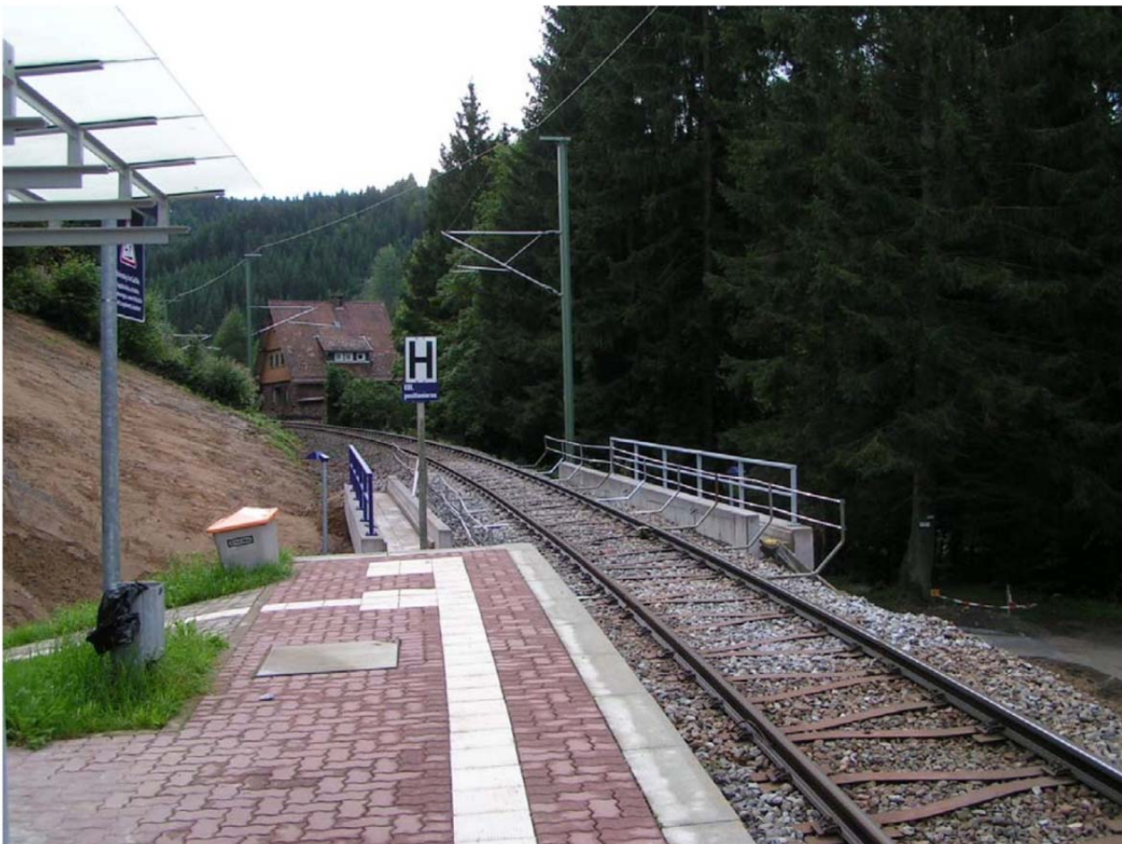
Kirchbaumwasen (der kürzeste Haltepunkt)-Gleise mit V-Schwellen-ein Vorgeschmack auf den nächsten Bauabschnitt...
