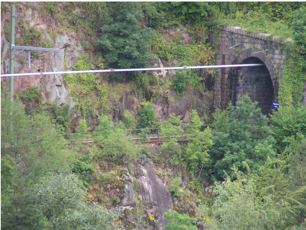
Tunnelfahrleitung bei Gausbach
